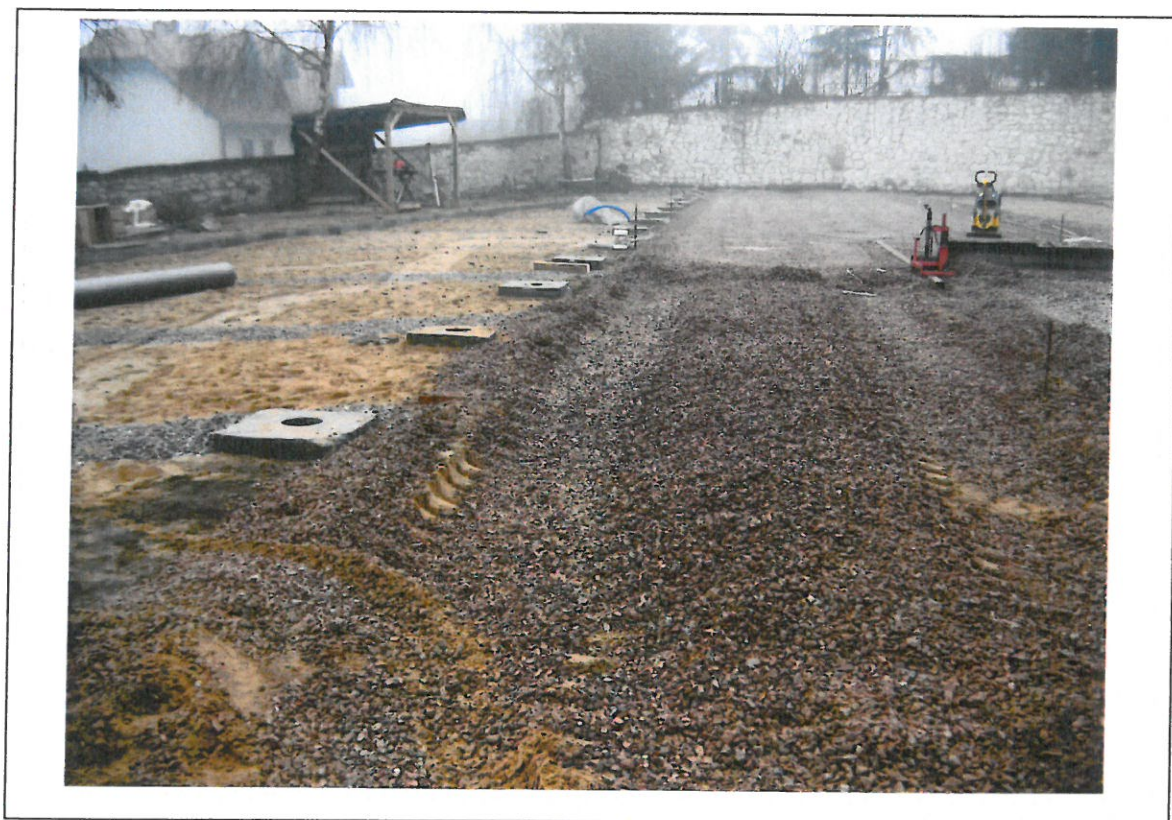
Fot. 12. Teren budowy po wykonaniu prac ziemnych. Ujęcie od strony wschodniej.
