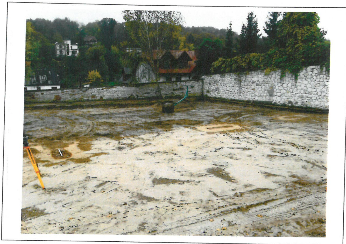
Fot. 1. Południowo – zachodnia część boiska po zdemontowaniu starej nawierzchni asfaltowej i wykonaniu niwelacji. Ujęcie od strony północno – wschodniej.
